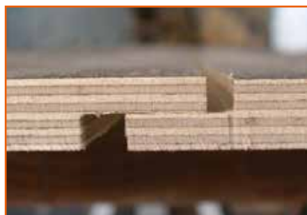
Particolare giunzione pianale
